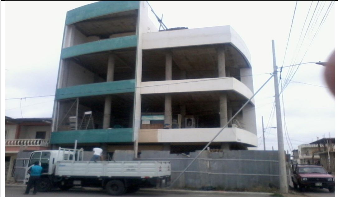
FACHADA PRINCIPAL DEL EDIFICIO EN CONSTRUCCIÓN
