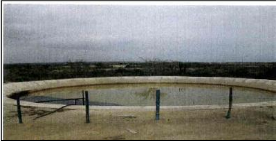
Figura 1.14. Piscina recolectora de agua de formación Fuente: Plan de Desarrollo del Campo Pacoa
