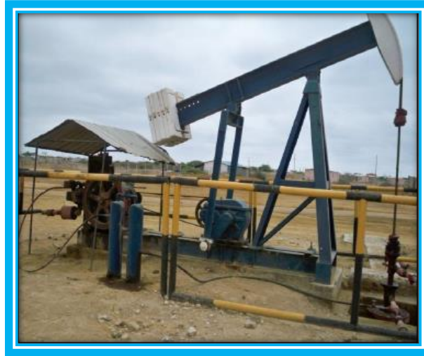
Fig. 1.8: Sistema de Levantamiento Artificial -BM- Fuente: PACIFPETROL S.A
