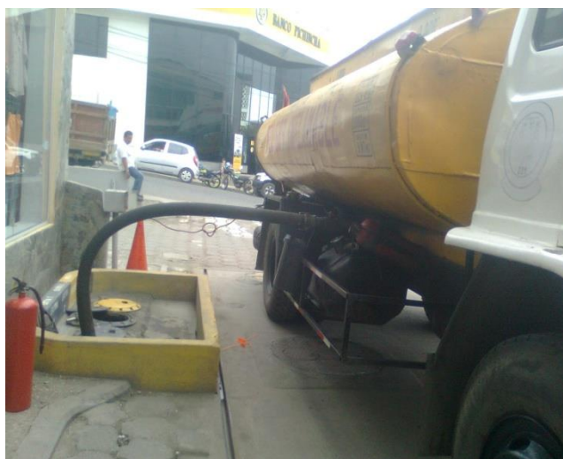
Anexo 7. Abastecimiento de la estación
