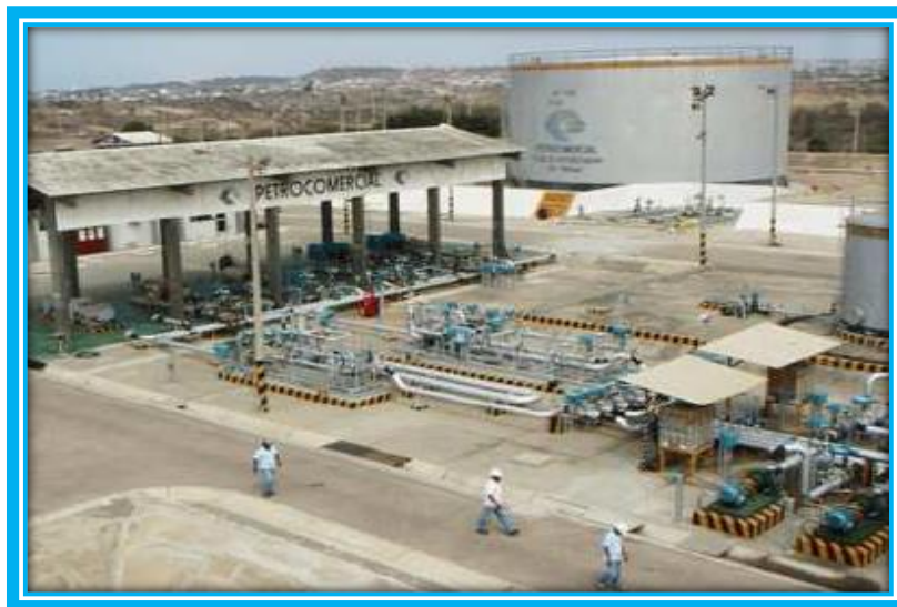
Fig. 1.10: Facilidades de Bombeo La Libertad
