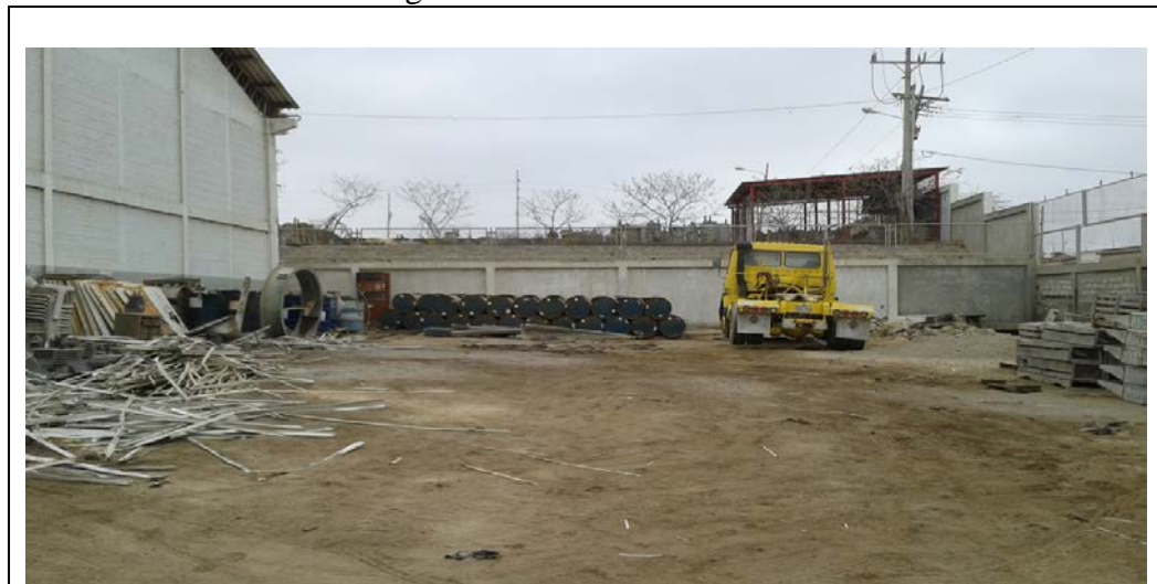
Imagen N° 12.- Lugar Destinado Para la Construcción de la Bodega de Residuos Peligrosos de CNEL-Santa Elena
