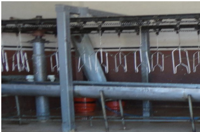
Pilar Metálico - INDUMONTAJE S.A
