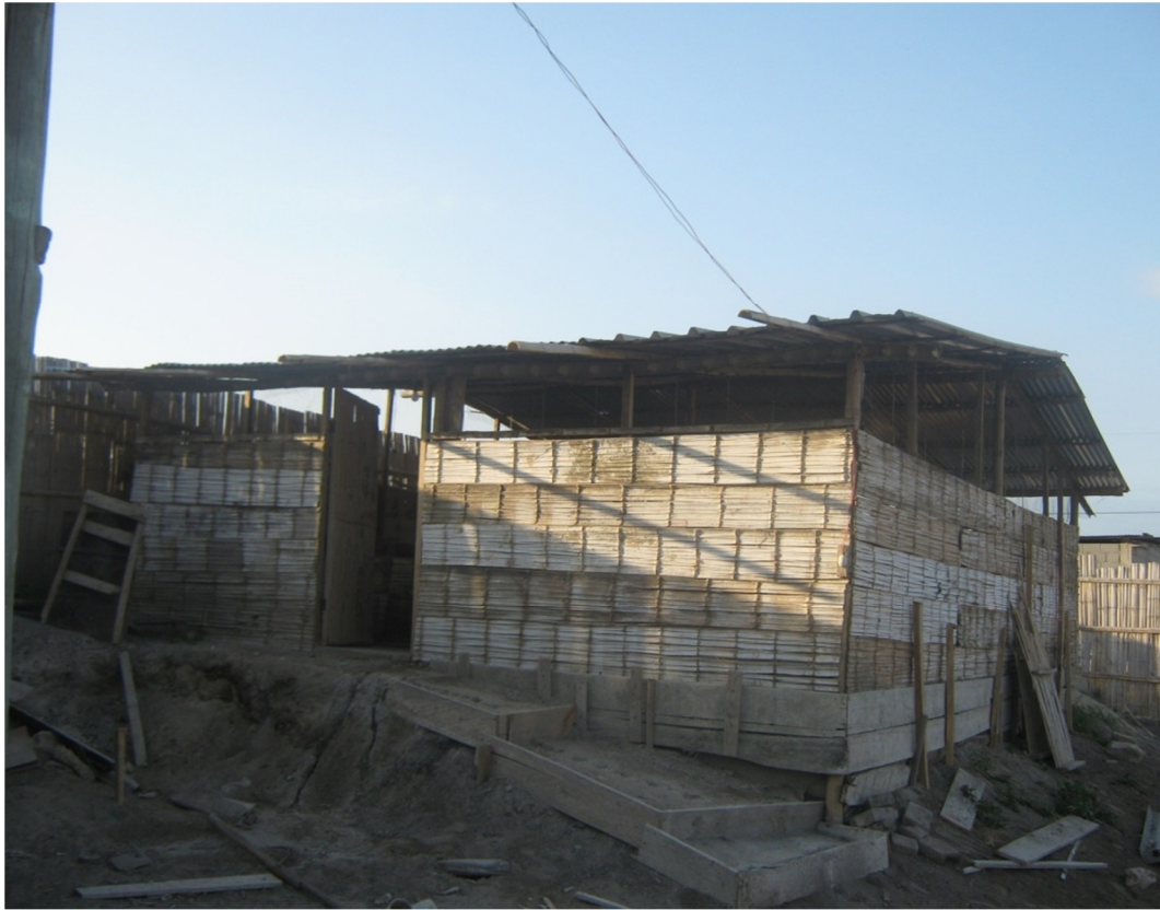
Fotografía 1. Construcción del galpón, Santa Elena 2013
