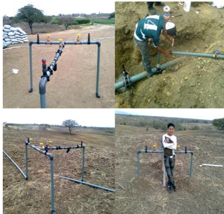
Fig. 6A Instalación de sistema de riego
