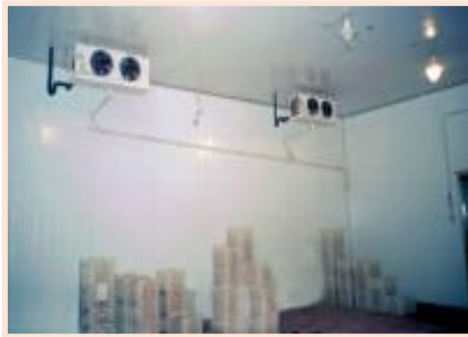
Figura 18. Parte interior de la cámara de frío.
