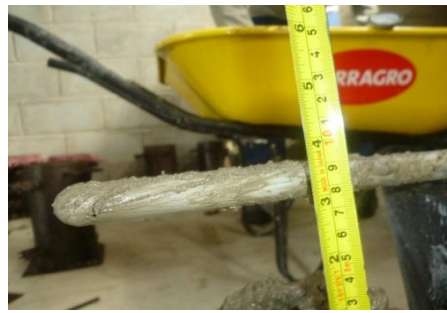
Medición de asentamiento de la mezcla
