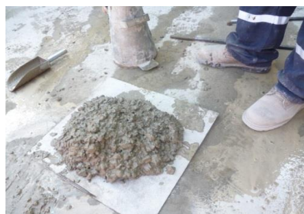
Medición de asentamiento de la mezcla
