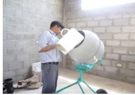
Colocación de materiales
