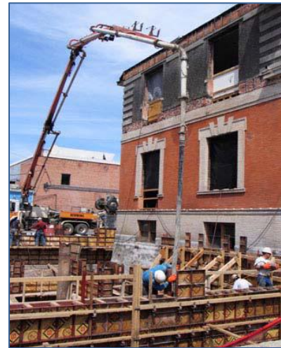
Figura 2.8. Vertido de hormigón. Fuente: Temas de hormigón armado_Marcelo Romo.
