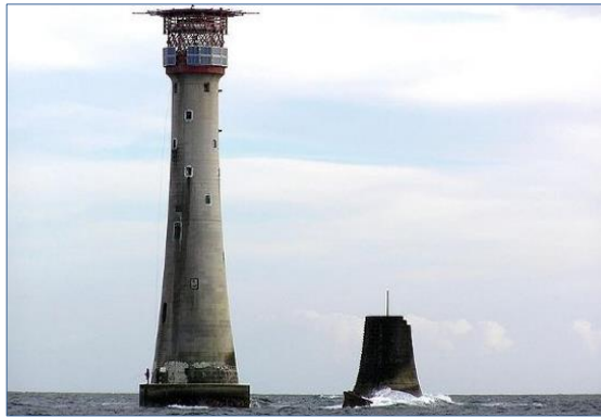
Figura 2.4 Faro del Acantilado de Eddystone en la costa de Cornwall. Fuente: Historia del hormigón.
