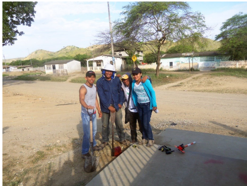
Foto 8: Colocación del hito H-UPSE
