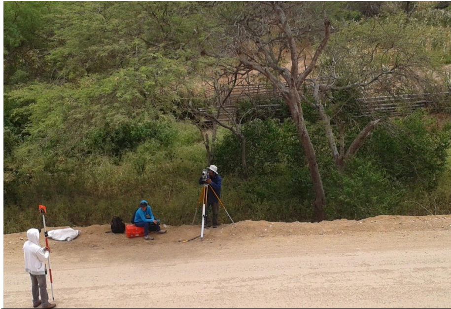
Foto 9: Fotografía tomada en la abscisa 3+230 realizando el levantamiento de la vía
