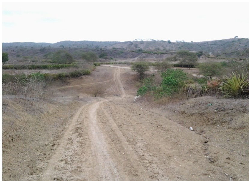
Foto 3: en la abscisa 4+200 se aprecia el cruce del río que afecta la continuidad de la vía.
