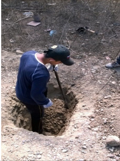
Foto 11: Excavación de calicatas
