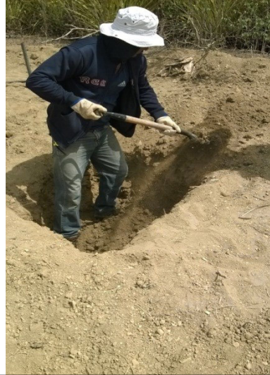
Foto 12: Excavación de calicatas
