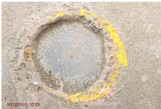
Foto 7: Placa L-M-21 ubicada en el puente sobre el Río Javita
