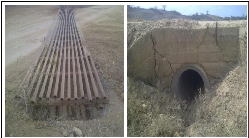
Gráfico N° 3. Protección de oleoducto y puente alcantarilla con tubo H.A. Fuente: Del Pezo - Muñoz
