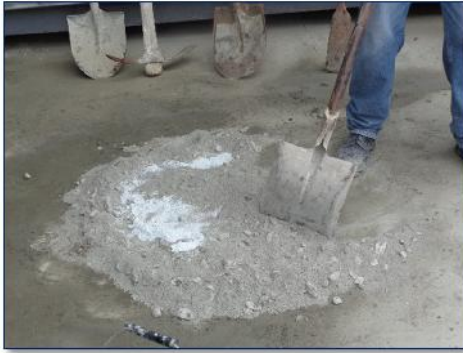
Ilustración 64.- Realizando la mezcla con polvo de vidrio. Fuente.- Autor.
