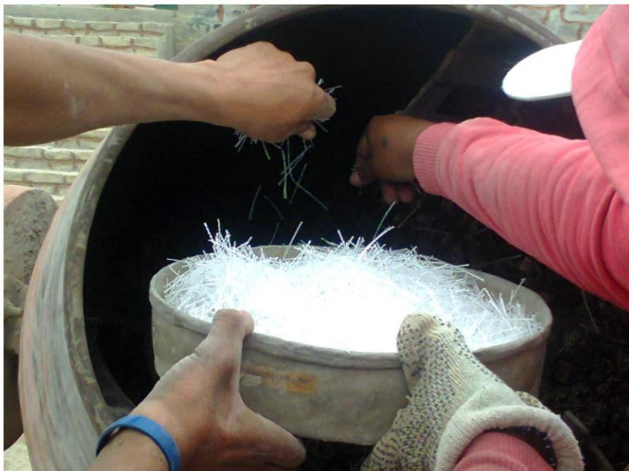
Colocación de las fibras de polipropileno al hormigón
