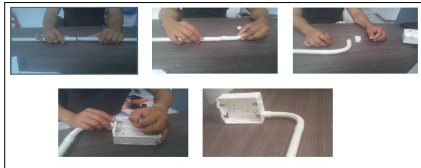
Figura 27: Armado de cajas pvc: Autor.
