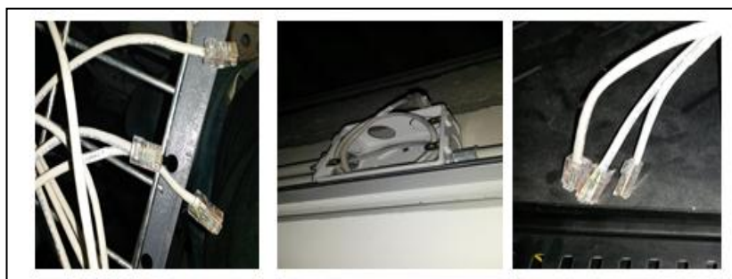
Figura 30: Ponchado cruzado para cámaras: Autor.
