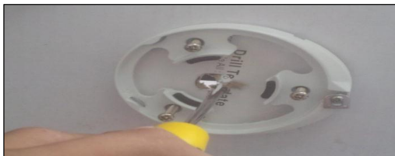
Figura 47: Marcar puntos de fijación de cámara IP: Autor.
