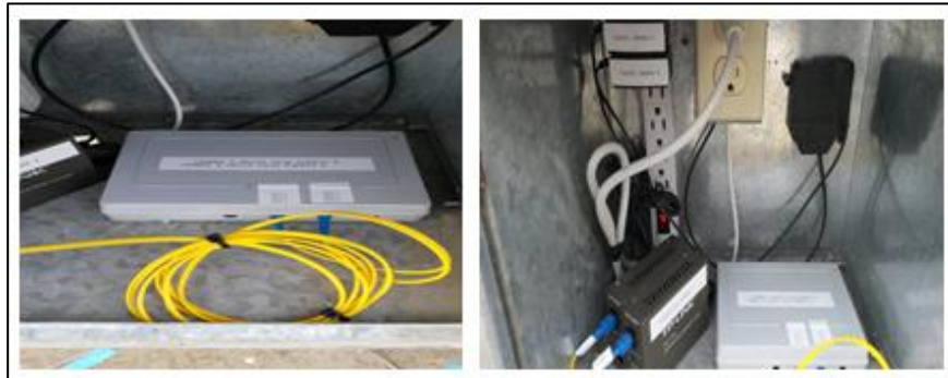
Figura 44: Identificación con etiquetas del Mini-ODF: Autor.
