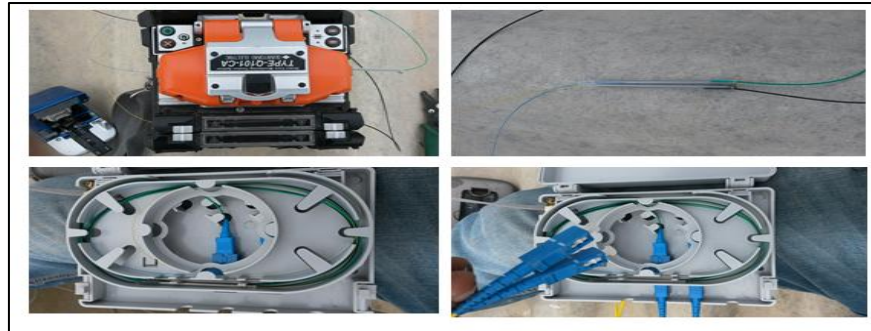
Figura 42: Fusión y armado en el min-ODF: Autor.
