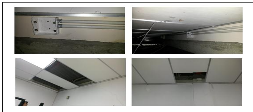
Figura 28 Colocación de los tubos y caja PVC: Autor.
