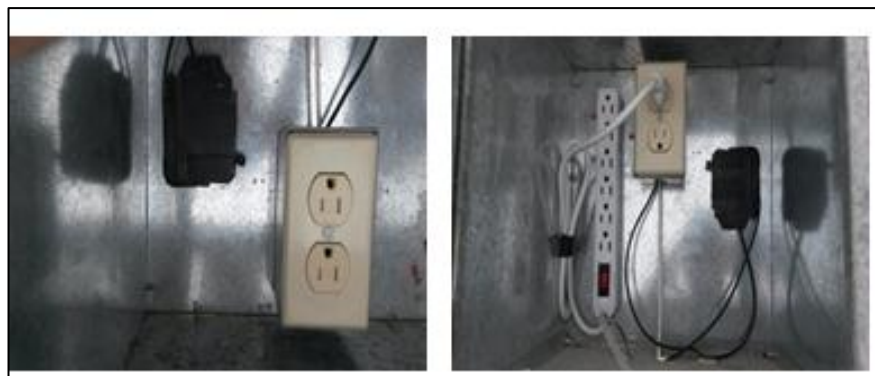
Figura 40: Ubicación de caja de alimentación eléctrica: Autor.
