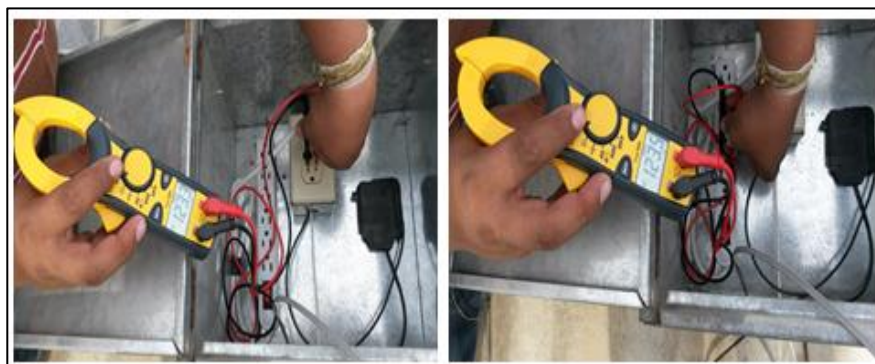
Figura 41: Comprobación de voltaje: Autor.
