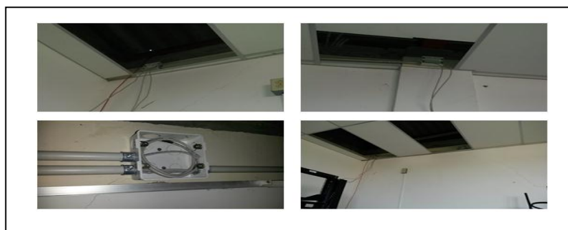
Figura 29: Paso de cable utp por ductos pvc: Autor.
