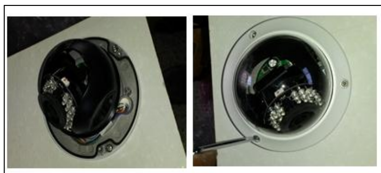
Figura 49: Estabilización de la cámara: Autor.
