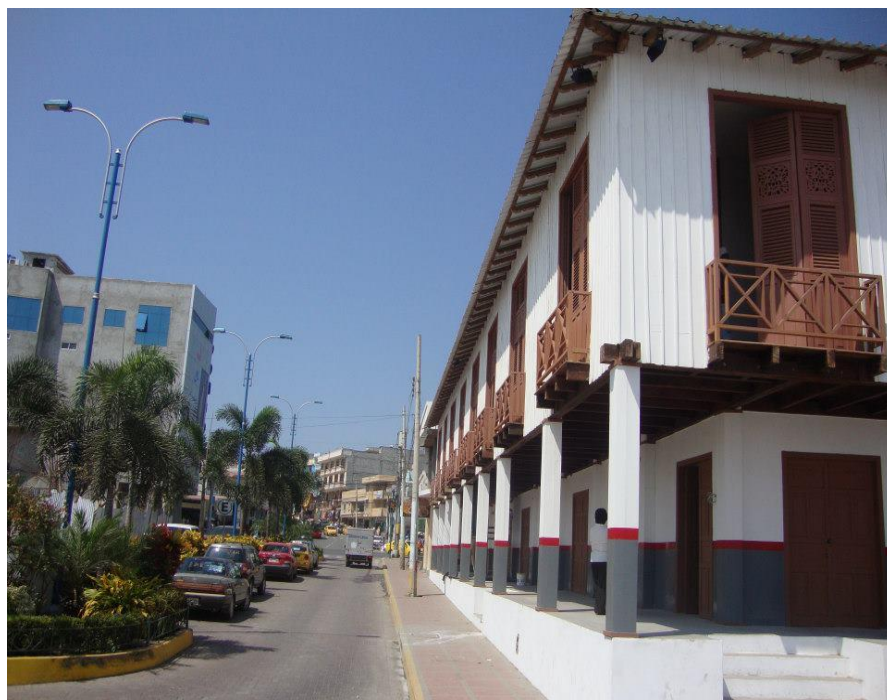
Fotografía 2 Calle Malecón CASA REMODELADA
