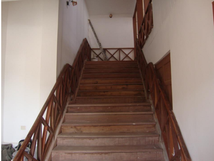
Fotografía 1 Escaleras de la casa
