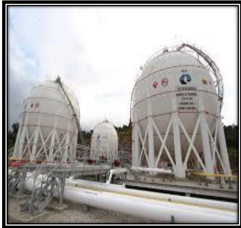
Figura 21. Almacenamiento de Gas
