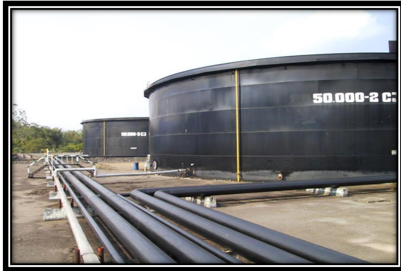
Figura 22. Tanques de Almacenamiento de Crudo
