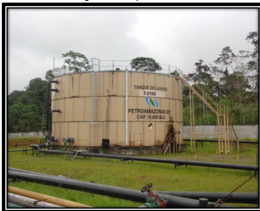
Figura 20. Tanque de lavado
