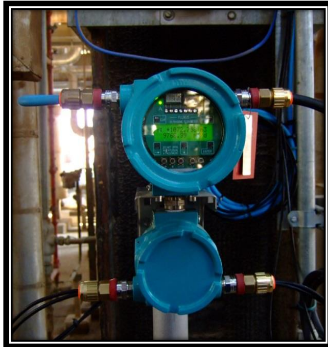
Figura 17. Medidor de Crudos
