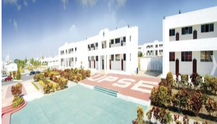
Figura 1: Infraestructura Universitaria: UPSE
