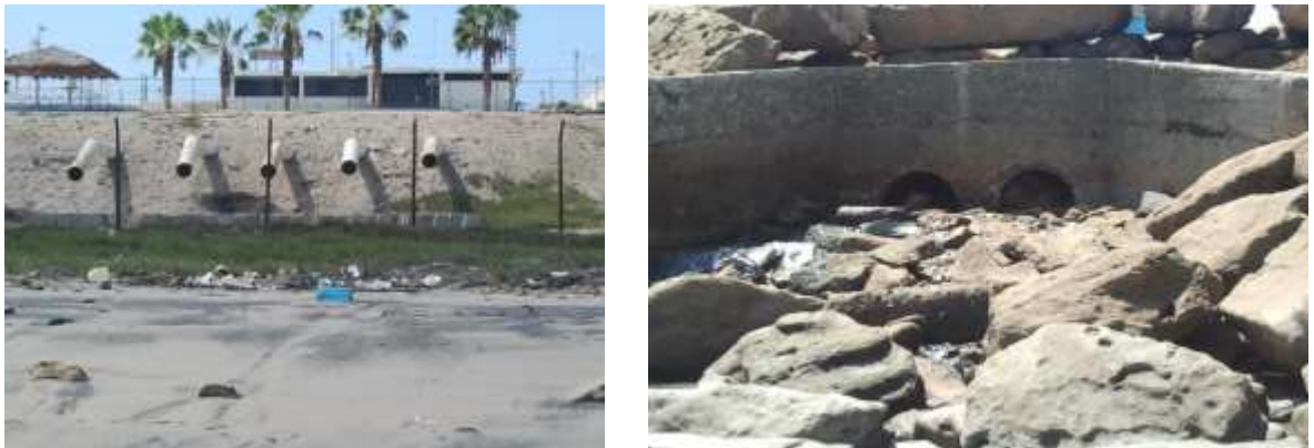
Gráfico 44 Tuberías de descarga al mar de aguas contaminadas
