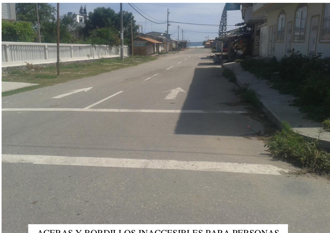
ACERAS Y BORDILLOS INACCESIBLES PARA PERSONAS CON DISCAPACIDAD
