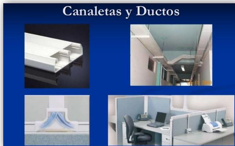
Figura 35 Canaletas o Ductos para el cableado Horizontal propuesto
