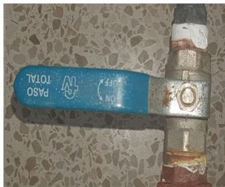
Figura 13: Válvula de Bola para el proceso de control
