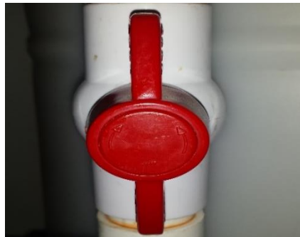
Figura 12: Válvula de Bola para permitir el paso del fluido en el proceso.
