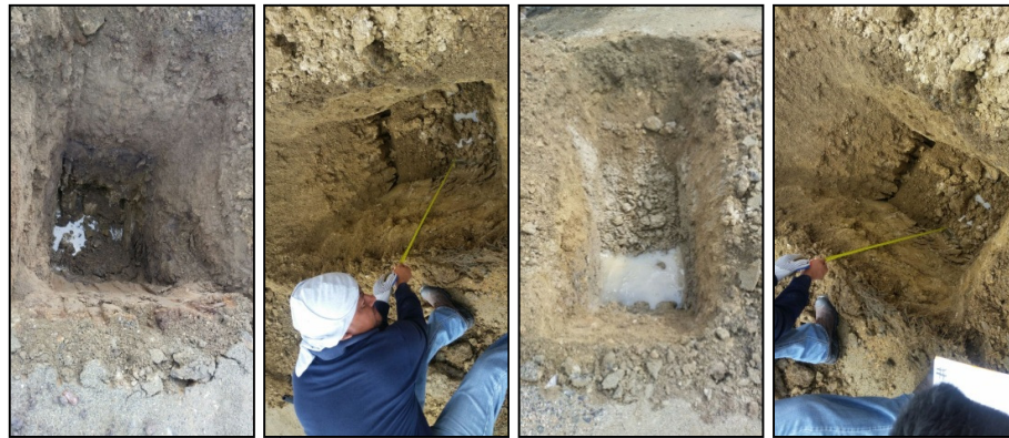
Figura 3.2. Excavación de Calicatas con presencia de Nivel Freático
