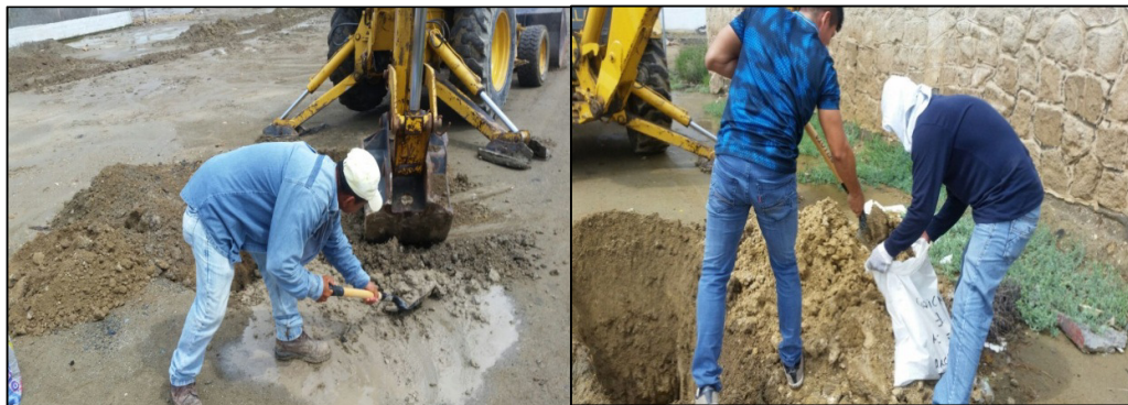
Figura 3.1. Extracción de muestras del suelo
