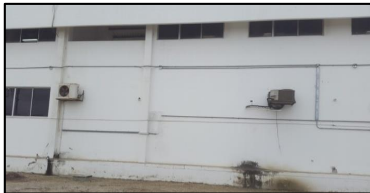
Figura 21: Distribución de cable en pabellón 1.
