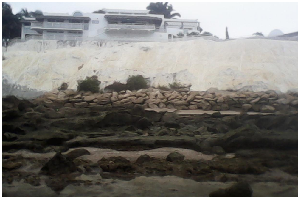
Fig. 21. Muro de contención contra la marea.
