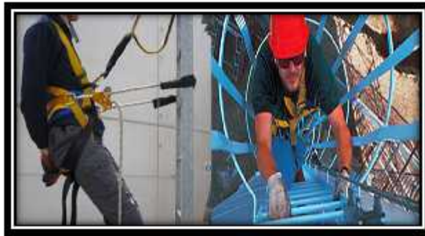
IMAGEN N° 54 PROTECCIÓN DE CAÍDAS
