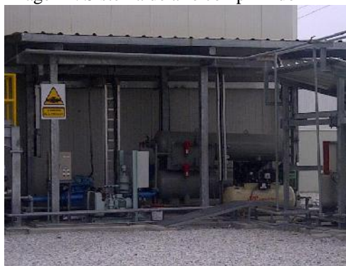
Imagen 2. Sistema de aire comprimido
