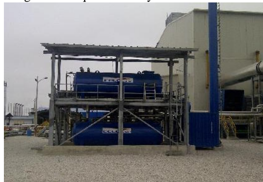
Imagen 3. Tanques MT-05 y MT-06
