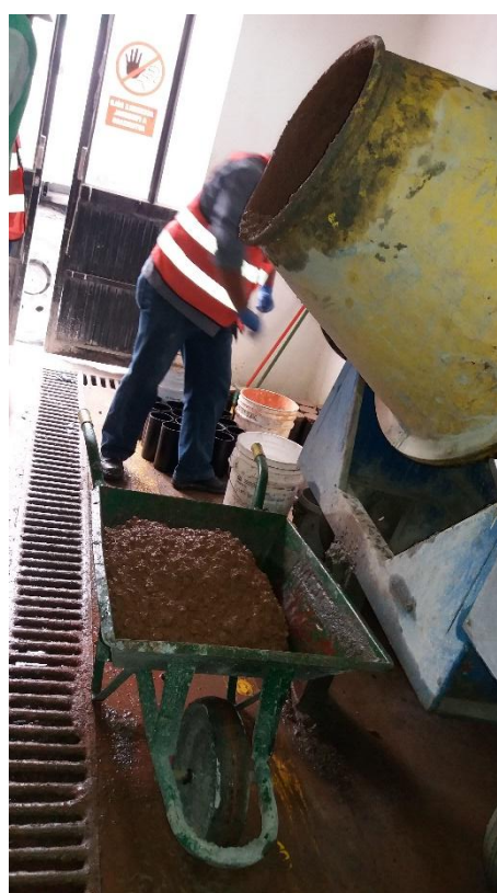
Figura 17 Vaciado de mezcla en carretilla para el respectivo llenado de probetas Fuente: M. Prudente, R. Vallejo
