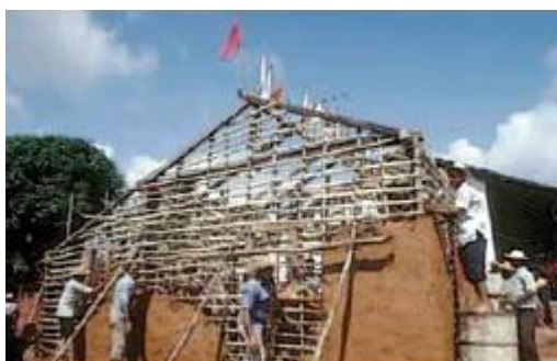
Figura 1 Construcción de Bahareque en Centroamérica: paredes de arcilla con tiras de madera
