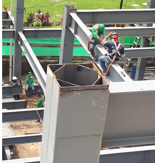
Gráfico 53: Sección HSS con placas internas (Construcción Ecuador).
