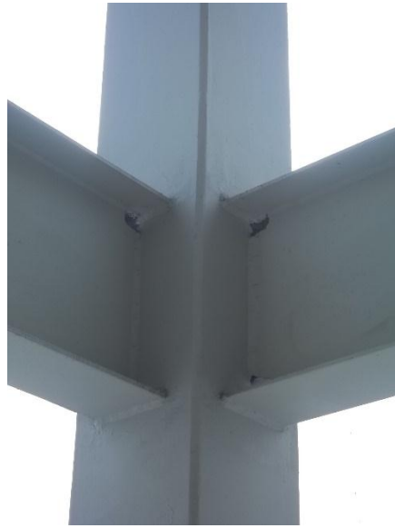
Gráfico 57: Conexión viga – columna soldada (Construcción Ecuador).
