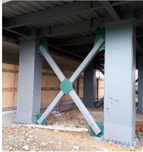
Gráfico 54: Pórticos especiales con arriostramiento en X en cada entrepiso (Construcción Ecuador).
