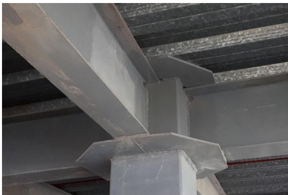
Gráfico 56: Conexión viga - columna (Construcción Ecuador).
