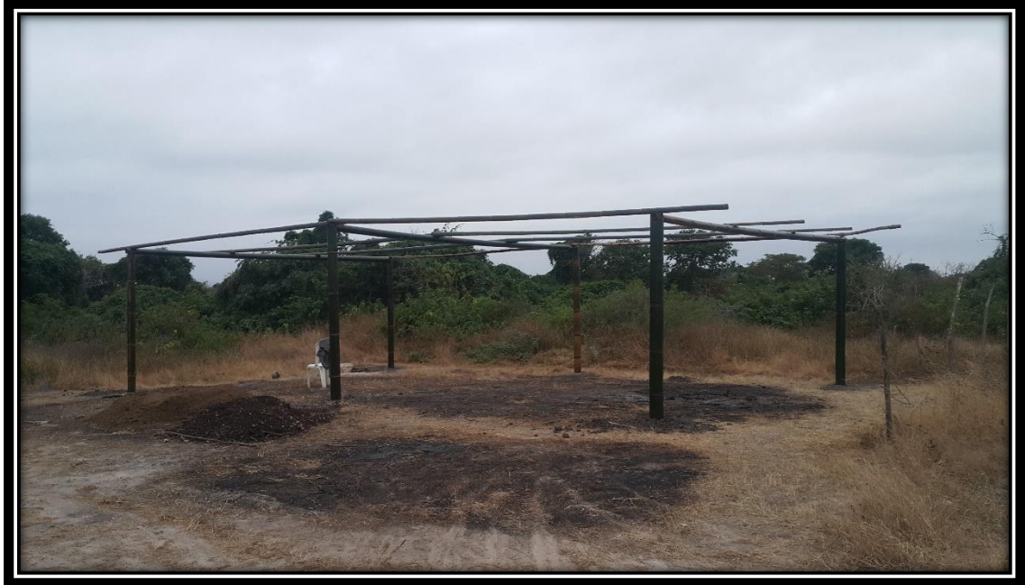
Figura 1A. Construcción de vivero para ensayo.
