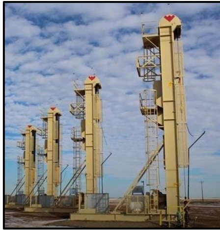
Figura 23: Unidad no API de bombeo Rotaflex.
