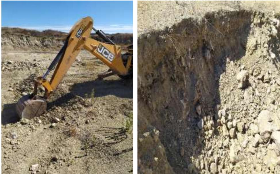
*Figura 12. Calicatas realizadas con la retroexcavadora*
