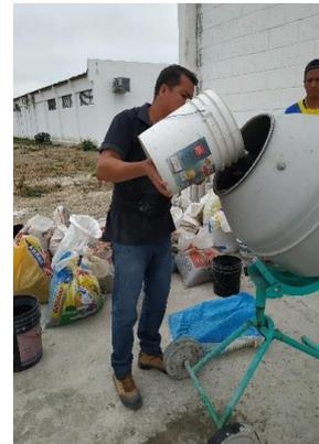
**Colocación de agua de mezclado**
