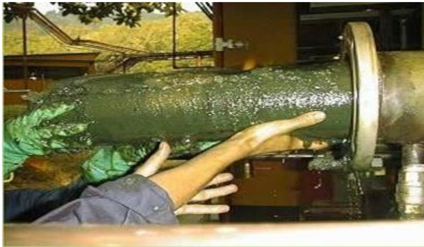
**Figura 2. Aspecto de la estructura gel formada en tubo de 6”.**
