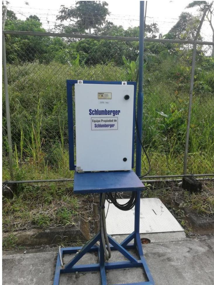
Figura 4.22: Transformador reductor (SDT).
