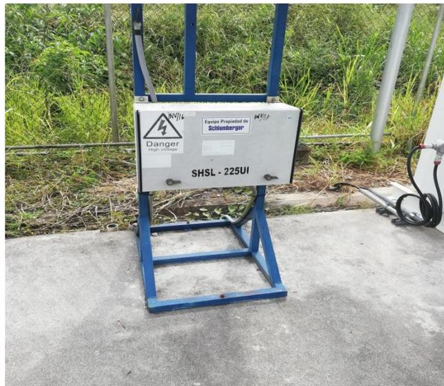
Figura 4.25: Transformador Elevador (SUT).
