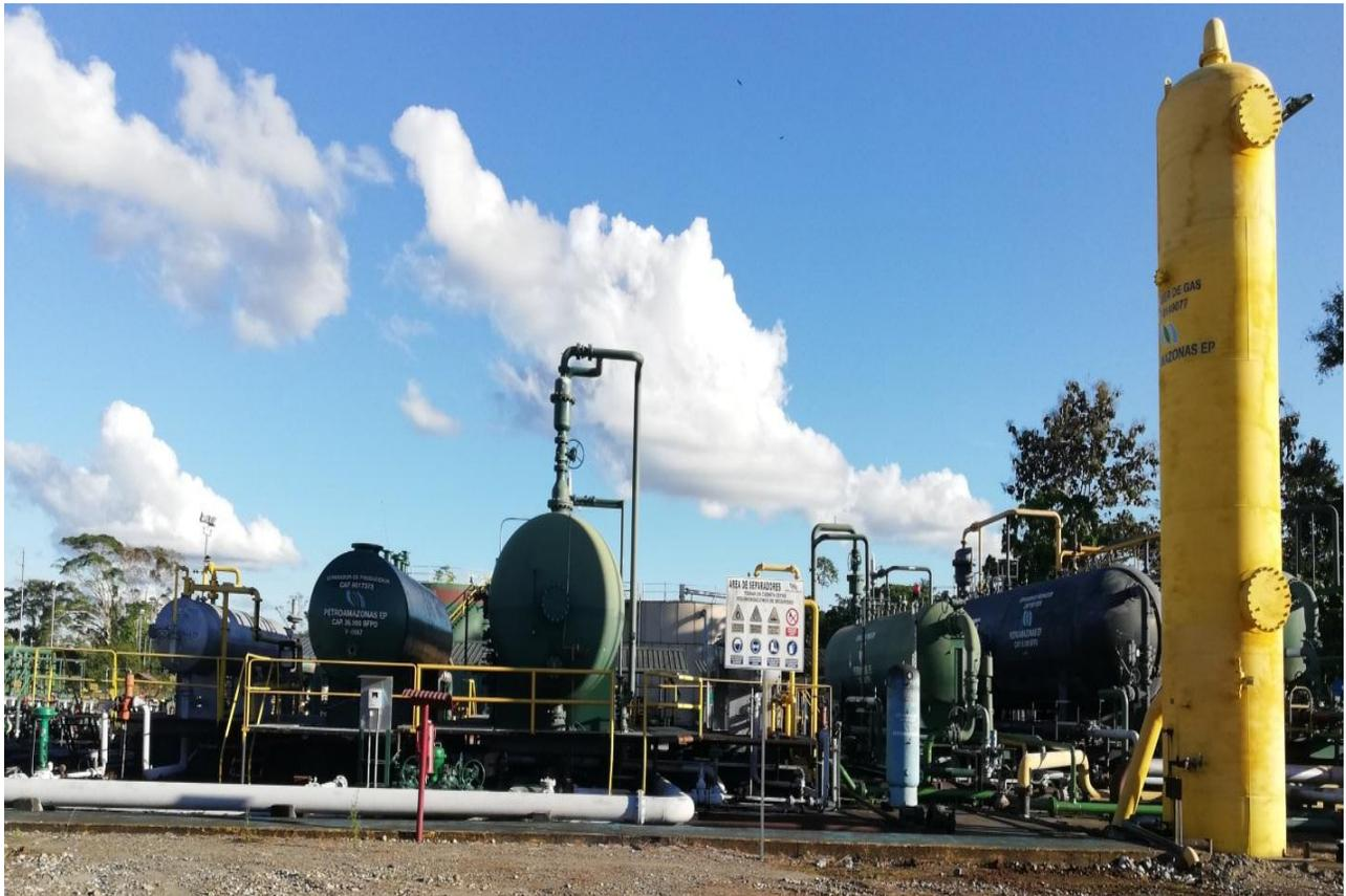
Figura 2.10: Separadores de prueba y producción + scrubber de la estación Sur
