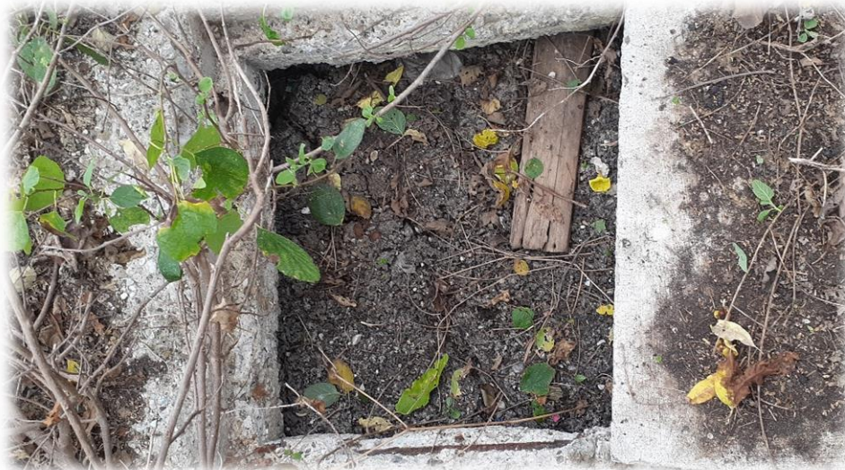
Foto #12: Estado actual de la cámara de ingreso de agua a las lagunas de estabilización.
