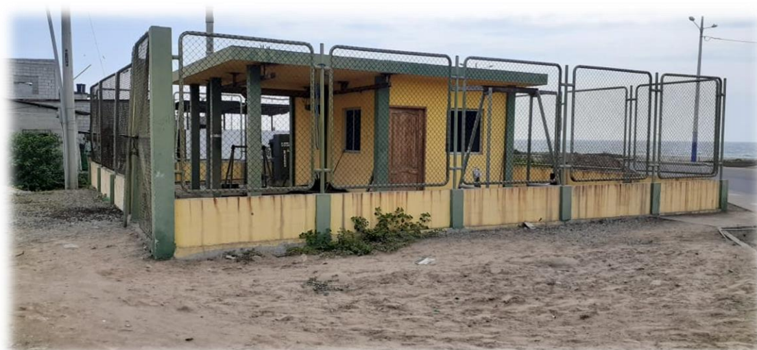
Gráfico# 23.- Estación de bombeo de San Pedro – Valdivia.
