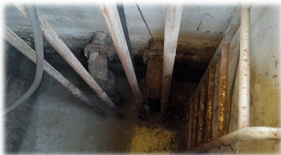
Gráfico# 24.- Cárcamo de bombeo, bombas sumergibles # 1 y # 2 y tubería de impulsión D=100mm, Estación de bombeo San Pedro-Valdivia
