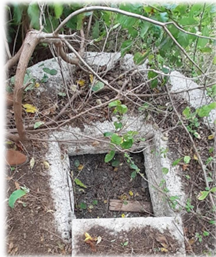
Gráfico# 32.- Cámara de ingreso a la laguna de estabilización (anaerobia),
