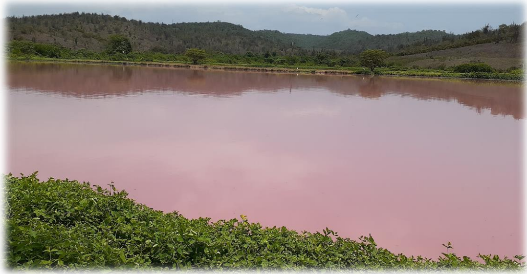
Foto #8: Laguna anaerobia.
