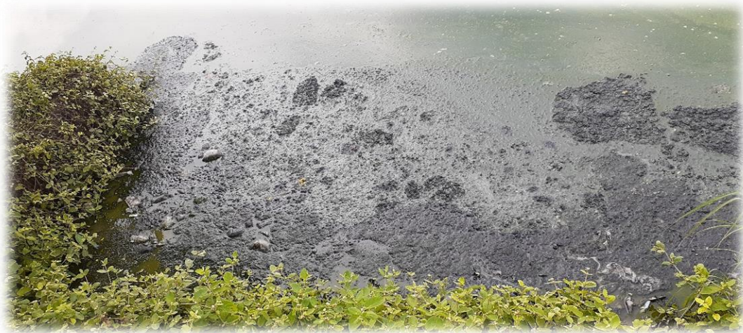
Foto #9: Sedimentación en las orillas de la laguna anaerobia.
