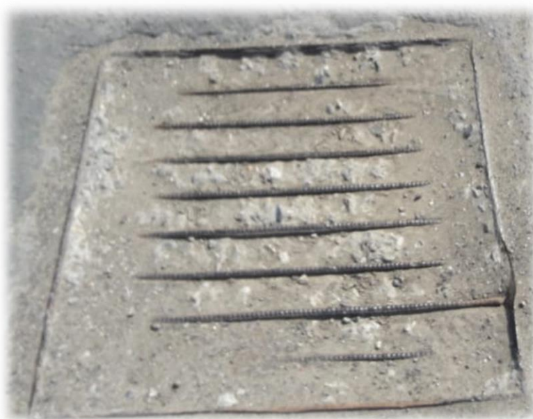
Foto #4: Estado actual de las tapas de H.S. de las cámaras principales.
