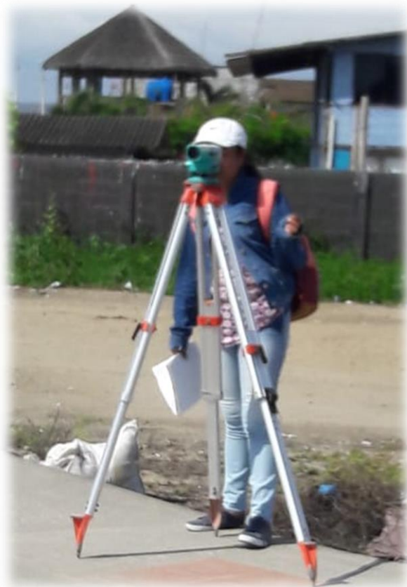
Foto #2: Nivelación de las cámaras principales de la red de alcantarillado Sanitario.
