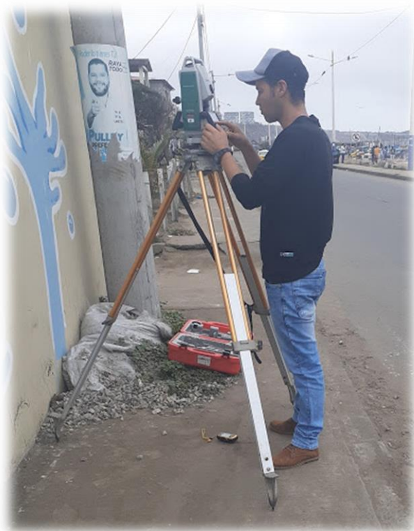
Foto #1: Levantamiento topográfico de la red de alcantarillado Sanitario.
