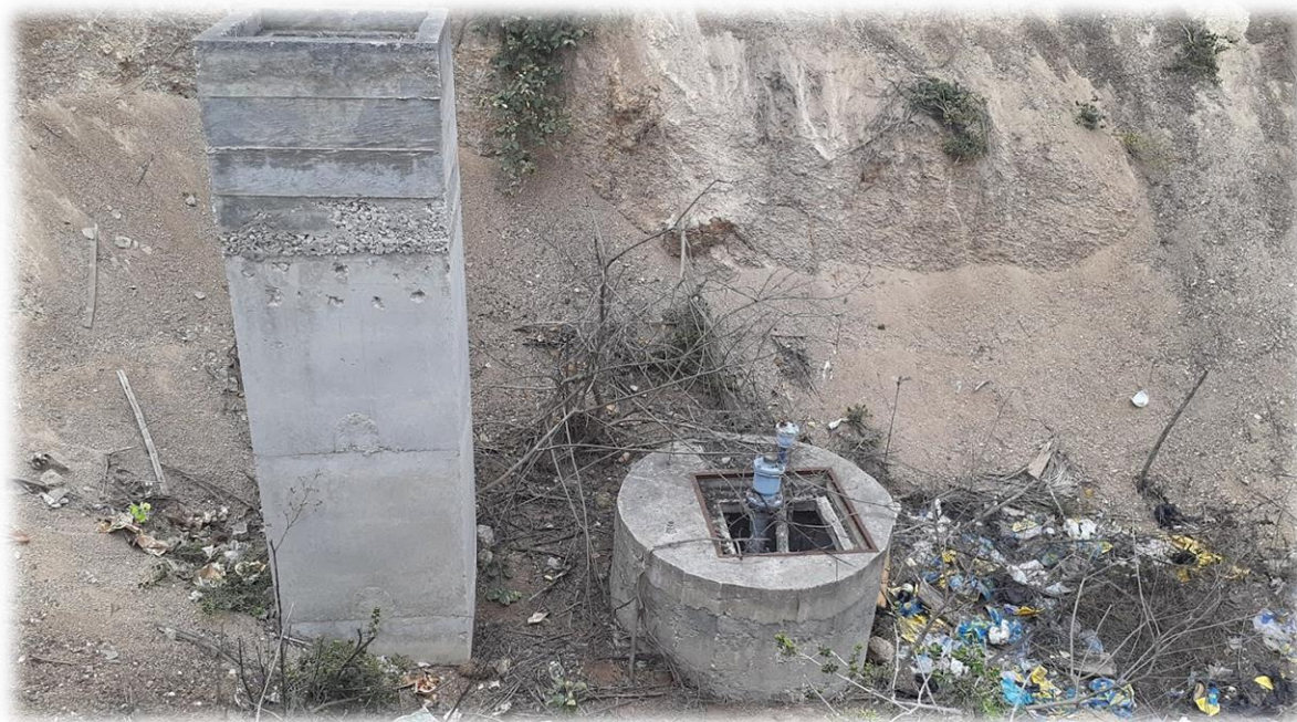
Foto #7: Inspección y ubicación de ventosas.
