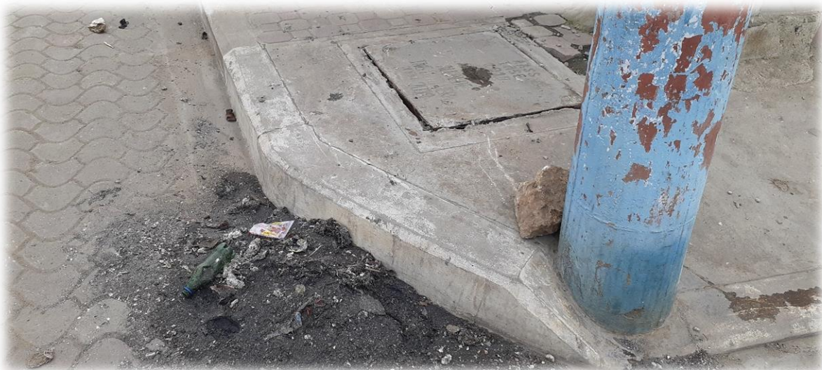
Gráfico# 19.- Caja domiciliaria AASS H.S. 0,6mx0,6 en la que se observa los residuos de arena y basura que obstruían el paso del flujo de agua residual.
