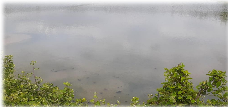
Foto #13: Presencia de sólidos suspendidos en la laguna de maduración.
