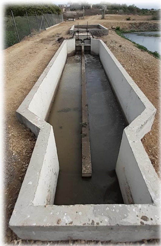
Foto #18: Visita e inspección al desarenador implementado en las lagunas de estabilización de Santa Elena.
