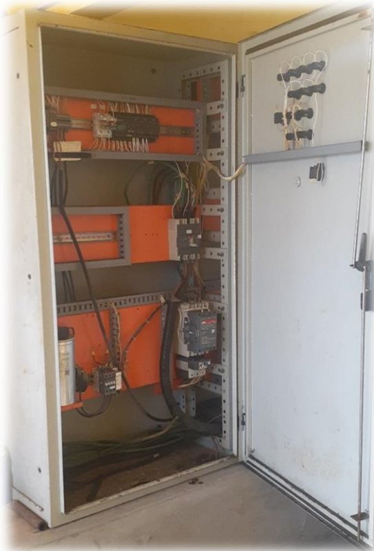
Foto #17: Tablero de control de bombas.
