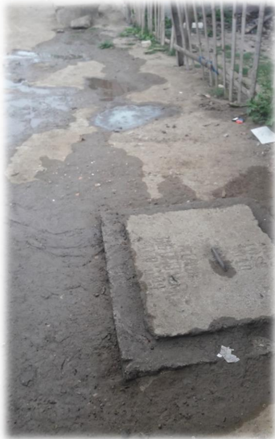
Gráfico# 18.- Caja domiciliaria AASS H.S. 0,6mx0,6 en la que se observa el rebose de sus aguas.
