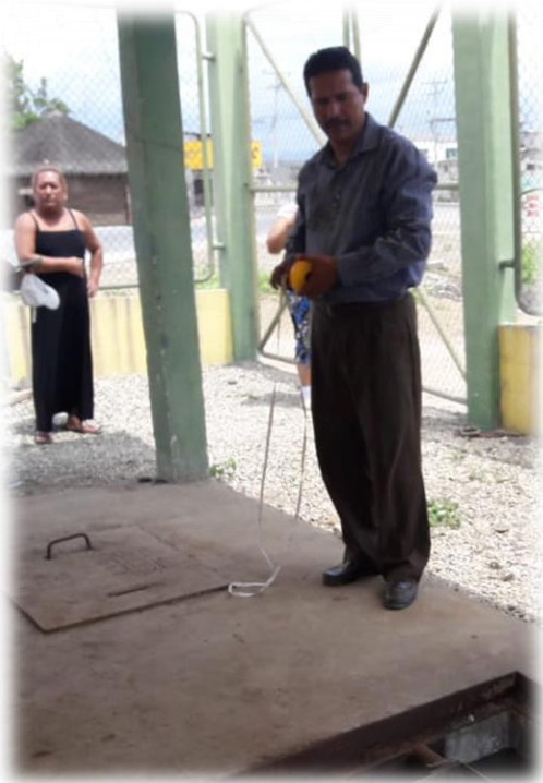
Foto #14: Visita e inspección a la estación de bombeo con el Ing. Richard Ramírez tutor de tesis.
