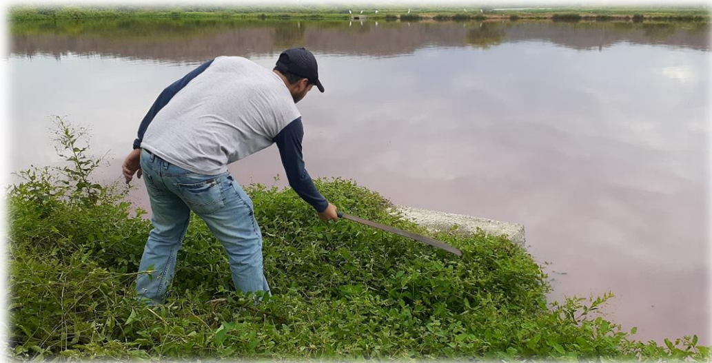
Foto #11: Limpieza de las cámaras que ingresan el agua residual a las lagunas de estabilización.
