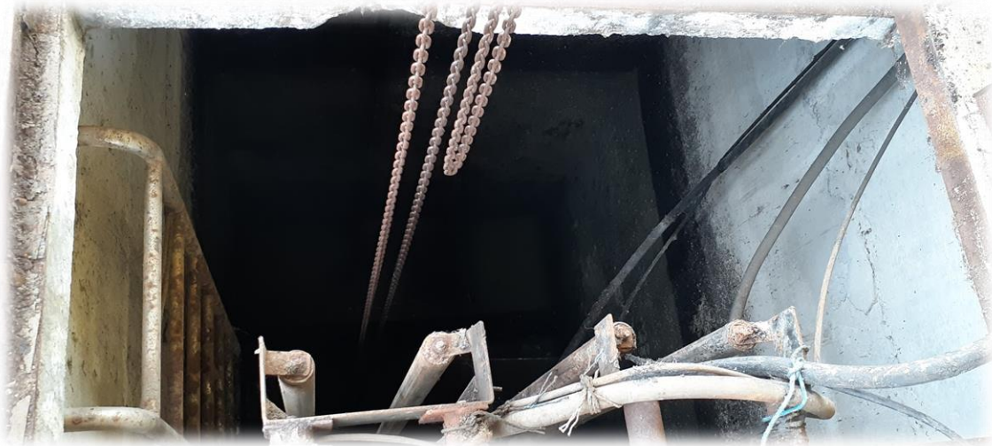
Foto #16: Poleas para la extracción de la bomba.
