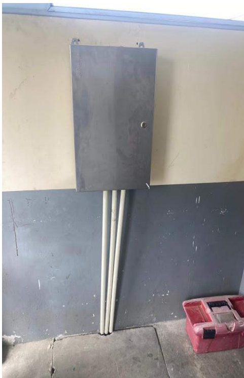
Anexo 13: Vista Tablero Control de los Seccionadores Motorizado.
