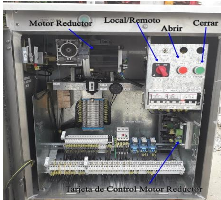
Figura 22: Vista Interna Tablero de Fuerza.
