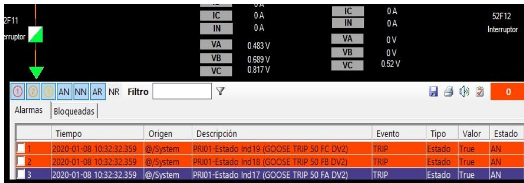
Figura 159: Alarma en el SCADA al recibir los disparos por la protección ANSI 50 mediante Goose.
