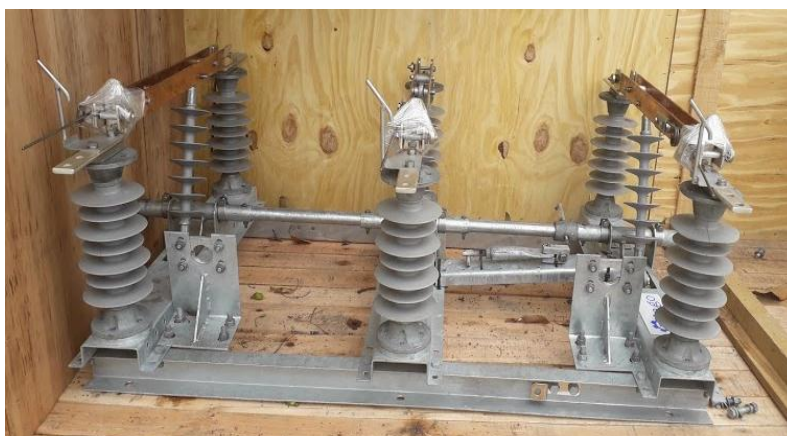
Figura 21: Seccionadores de Media Tensión (Equipo de Fuerza).
