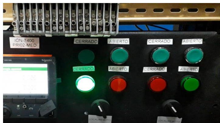
Figura 179: Ejecución mando “cerrar” IED ZIV 2IRX.
