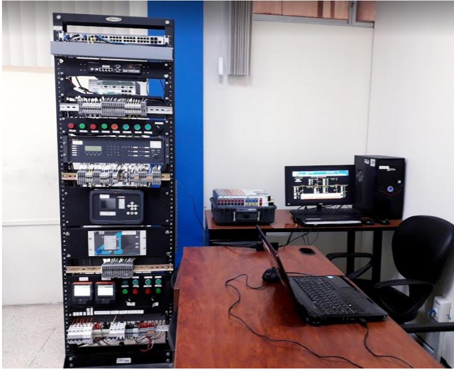
Anexo 9: Implementación módulo de pruebas con el SCADA Local en el COD-STE.
