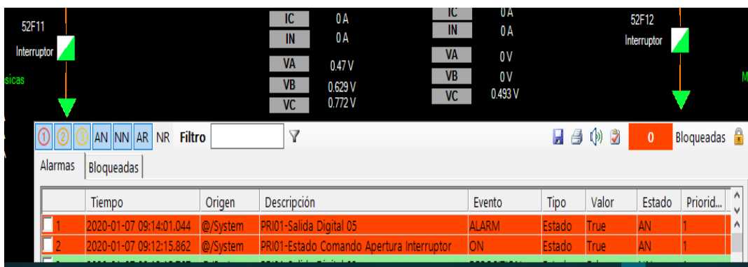
Figura 176: Alarma en el SCADA accionamiento salida digital.
