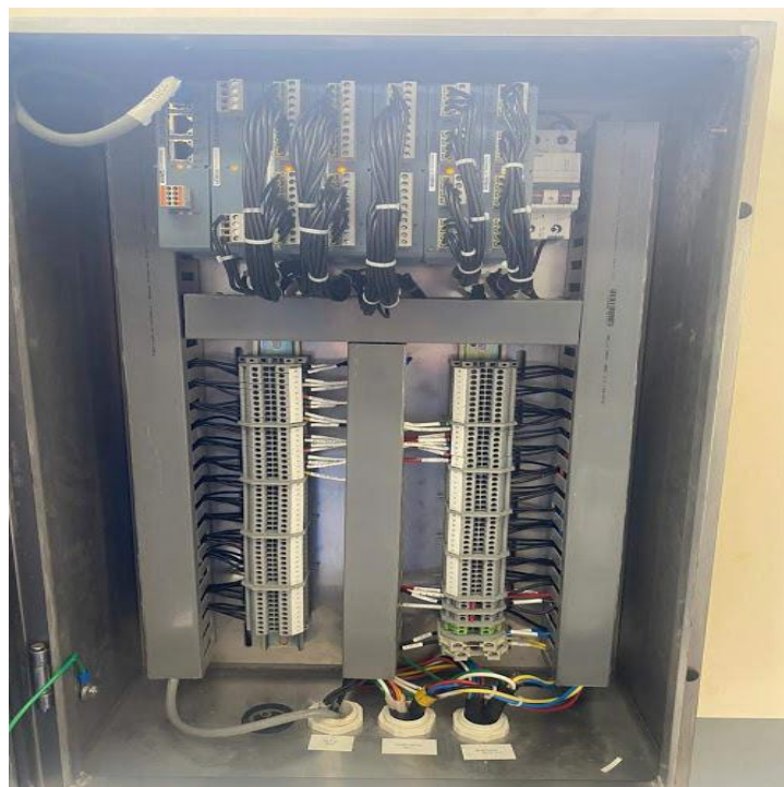
Figura 41: Ubicación tablero de control seccionadores motorizados.
