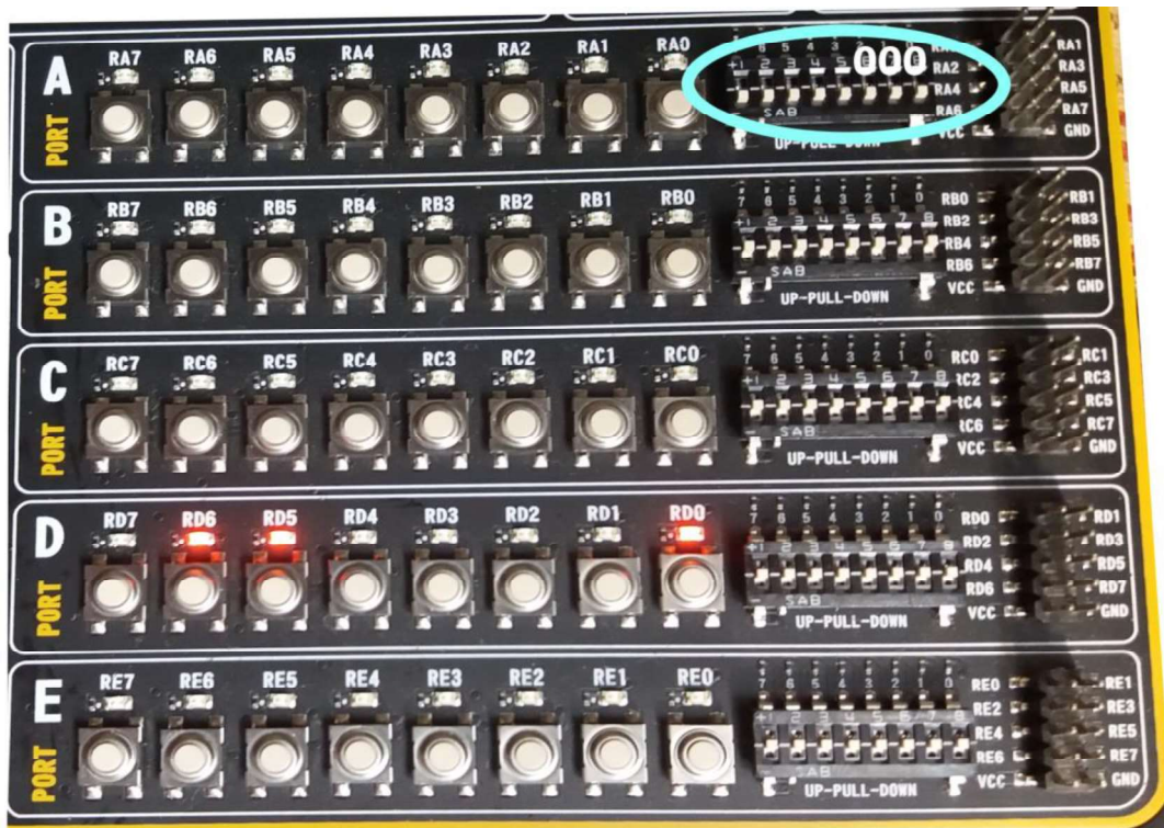
Ilustración 55 Cuando ninguno sensor detecta la presencia de líquido
