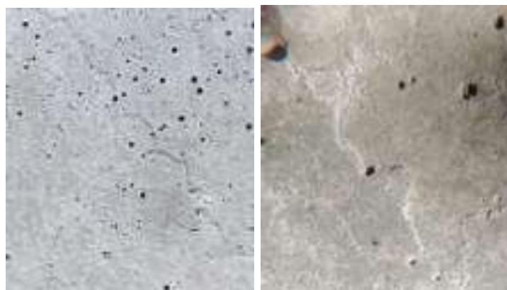
Figura 7: Fenómeno de curación con carbonato de calcio Fuente: (Cabezas Cantos, 2020)
