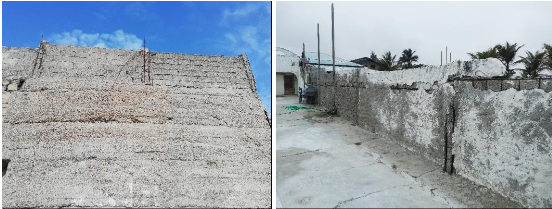
Figura 16. Pilares de Cerramiento. Armaduras excesivamente expuestas y con importante pérdida de sección por corrosión. Eflorescencias en la superficie del hormigón en forma de costra blanca.
