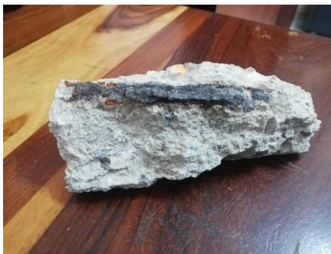
Figura 25. Hormigón carbonatado Caso B
