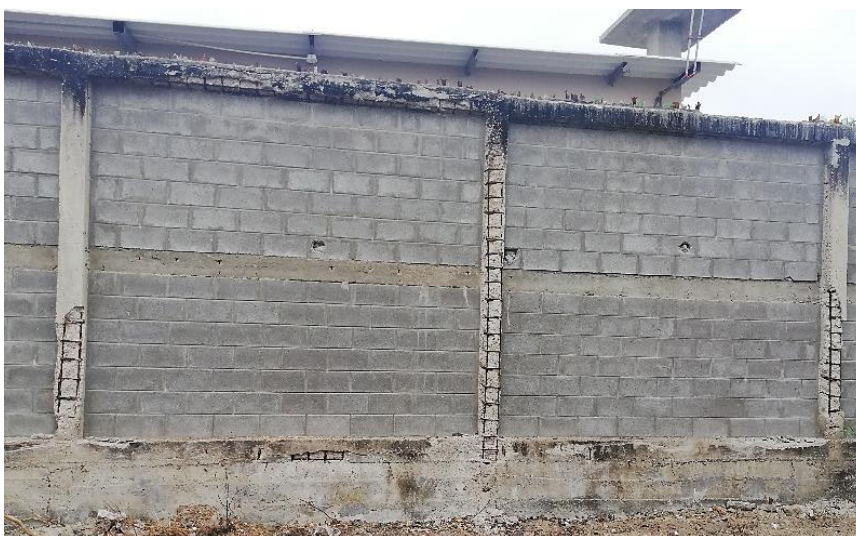
Figura 10. Columnas del eje A con desprendimiento excesivo del hormigón de recubrimiento. Viga de Riostra con manchas de óxido en las proximidades del acero afectado por corrosión.
