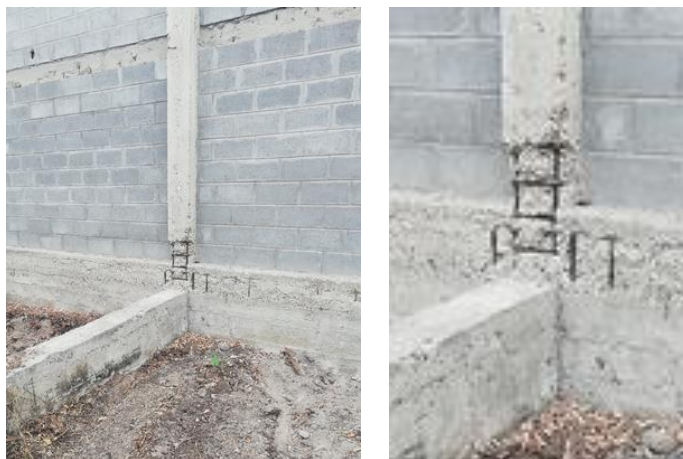
Figura 9. Conexión Viga de riostra –Columna. Pérdida de hormigón de recubrimiento con acero expuesto afectado por corrosión.
