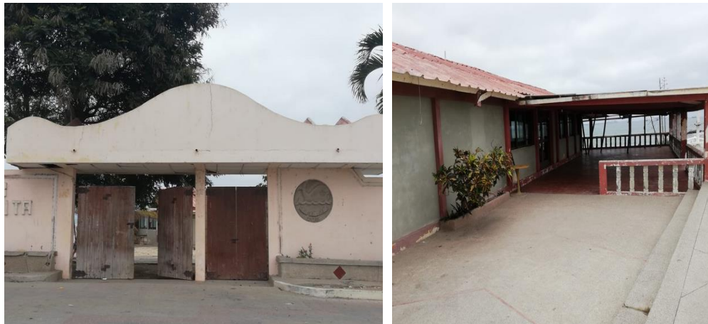
Figura 17. Elementos estructurales de fachada frontal y de áreas de reuniones. Presentan un buen estado en general.
