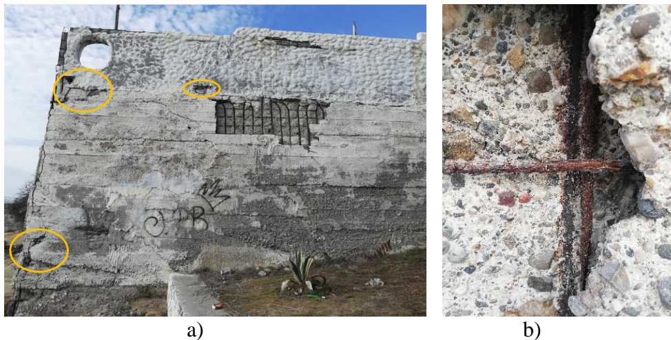
Figura 15. a) Vista exterior de muro. Presencia de eflorescencias generalizadas. Cavidades a lo largo del muro. b) Pérdida importante de sección en la armadura
