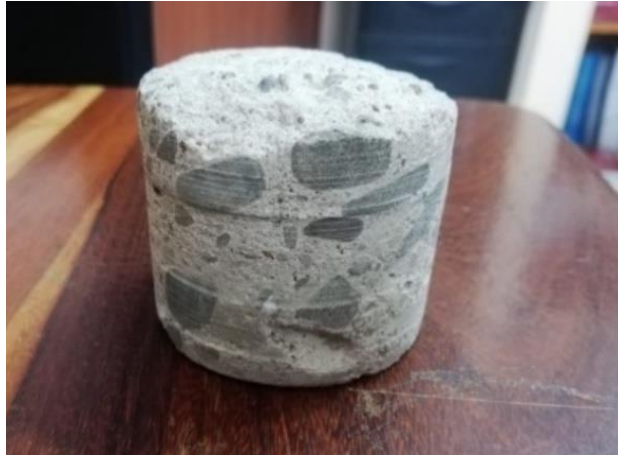
Figura 24. Hormigón carbonatado Caso A
