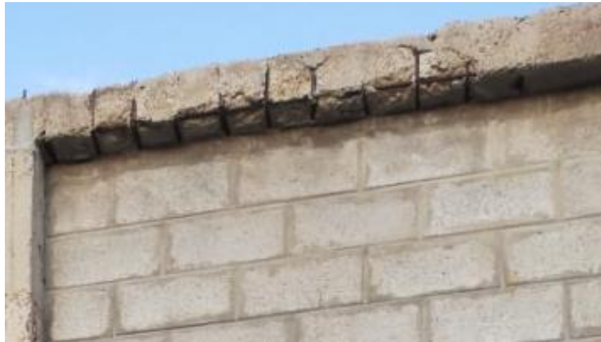
Figura 12. Viga superior del eje D. Deterioro moderado de hormigón de recubrimiento. No se aprecia pérdida excesiva de sección de la armadura.
