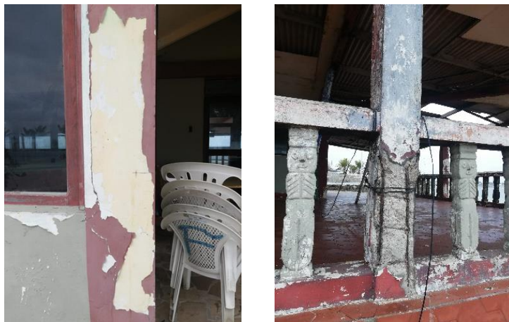
Figura 18. Columnas de áreas de reuniones situadas más cerca de la zona de salpicaduras. Fisuras de hasta 5 mm. Pérdida local de hormigón y pérdida severa de sección de armadura por corrosión.
