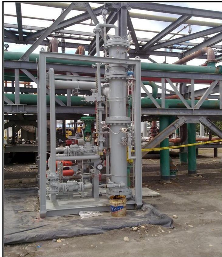
Figura 12. Separador de prueba GLCC.
