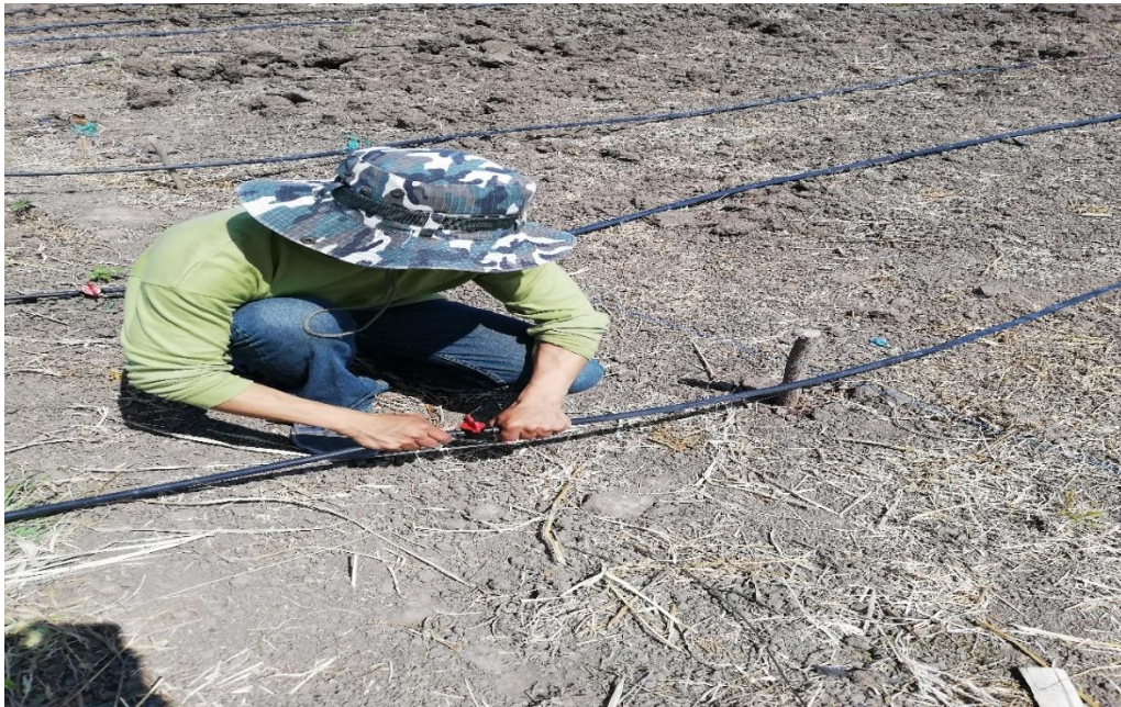
Figura 1A. Instalación del sistema de riego
