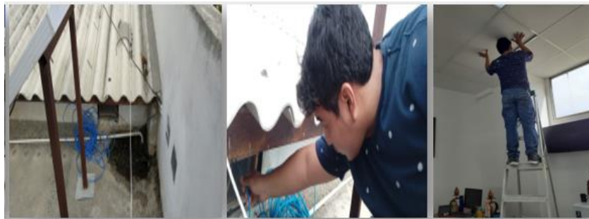
Ilustración 11 Inserción de cableado y canaletas parte 2 Elaboración: Propia
