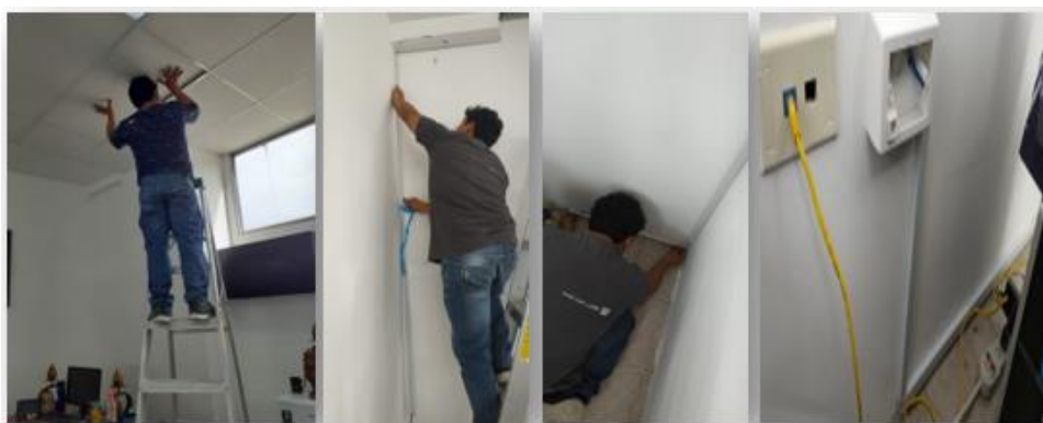
Ilustración 12 Inserción de cableado y canaletas parte 3 Elaboración: Propia
