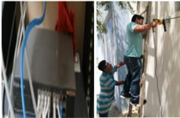
Ilustración 10 Inserción de cableado y canaletas parte 1 Elaboración: Propia
