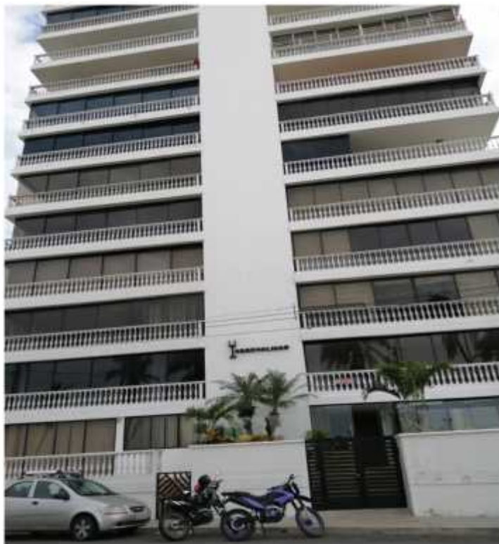
Edificio Torremolinos – Sector Palmeras
