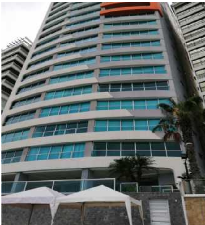
Edificio Vista Mar.- Sector San Lorenzo
