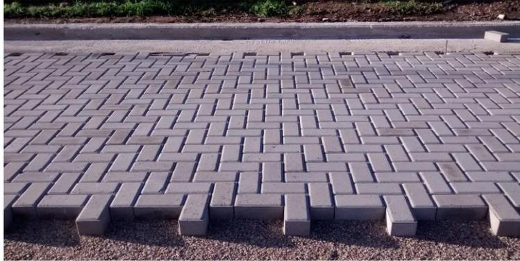
Nota. El gráfico representa la colocación del adoquín en el pavimento articulado para uso peatonal.
