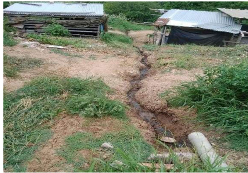
Anexo 4A. Erosión de suelo por orina y agua de limpieza.
