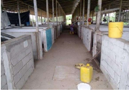
Anexo 1A. Galpones con una buena estructura.
