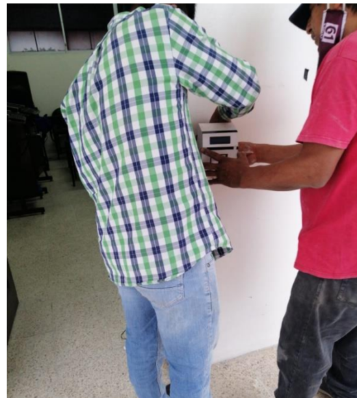
Figura 58. Instalación del dispositivo de seguridad a un costado de la puerta de acceso.
