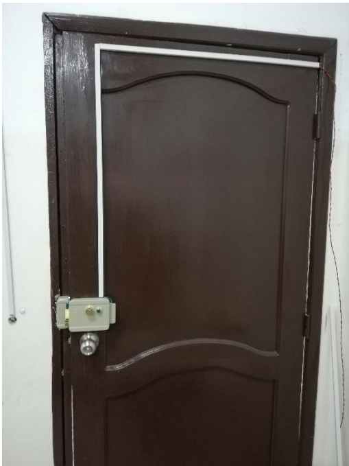
Figura 59. Conexión e instalación de cerradura eléctrica
