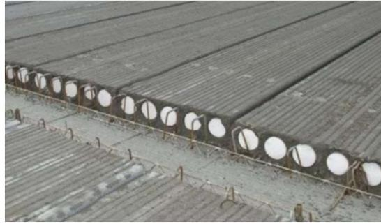
*Nota.* Imagen representativa de pavimento de hormigón pre o postensado.
