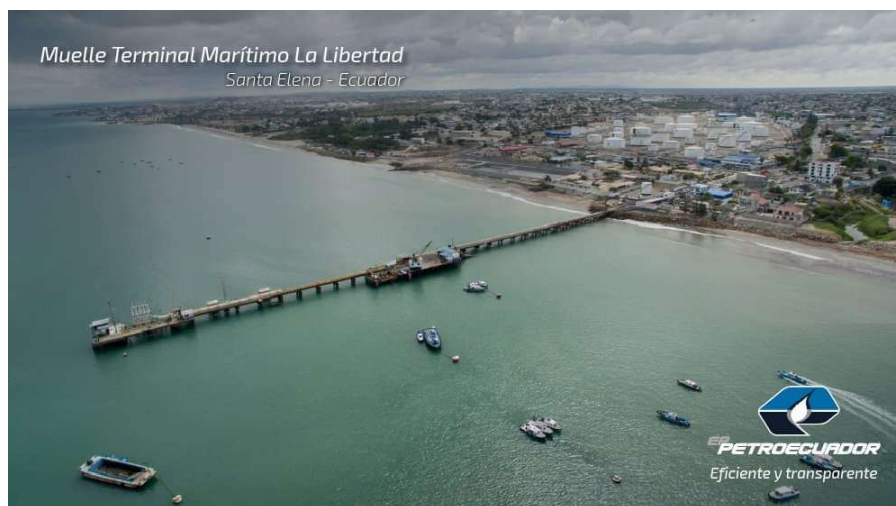
Figura 1. Muelle Terminal Marítimo La Libertad. Fuente: EPPETROECUADOR 2020.
