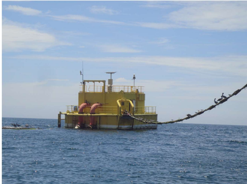
Desamarre del cabo de la monoboya.
