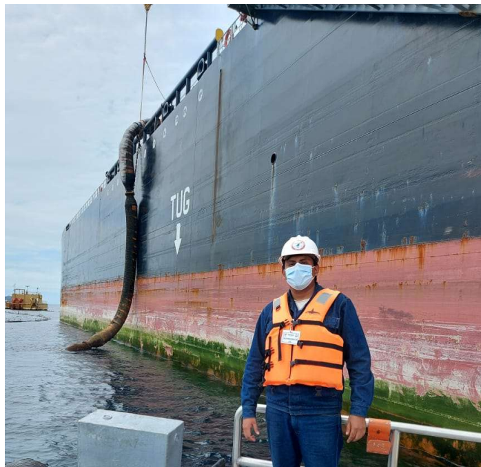
Conexión de la manguera flotante.
