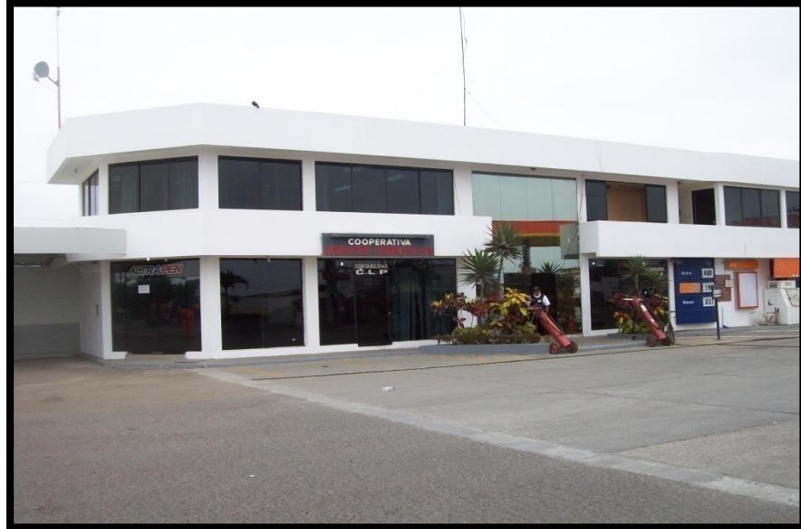
EDIFICIO PRINCIPAL DE CLP, UBICADO EN EL CANTÓN LA LIBERTAD BARRIO GENERAL ENRÍQUEZ GALLO
