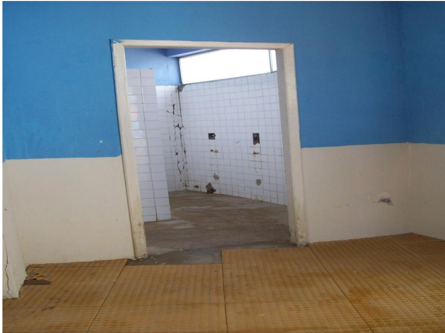
Fuente: Complejo Baños de San Vicente, Baños/ Elaborado por Alexis Suarez
